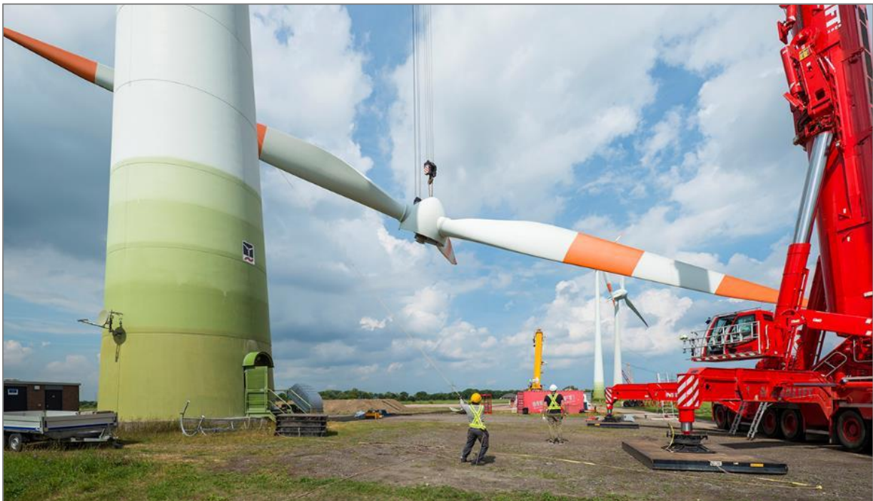
Abb. 8: Betonturm beim Abbau der Rotorblätter als ganzer Rotorstern (© Hagedorn Unternehmensgruppe, www.unternehmensgruppe-hagedorn.de )
