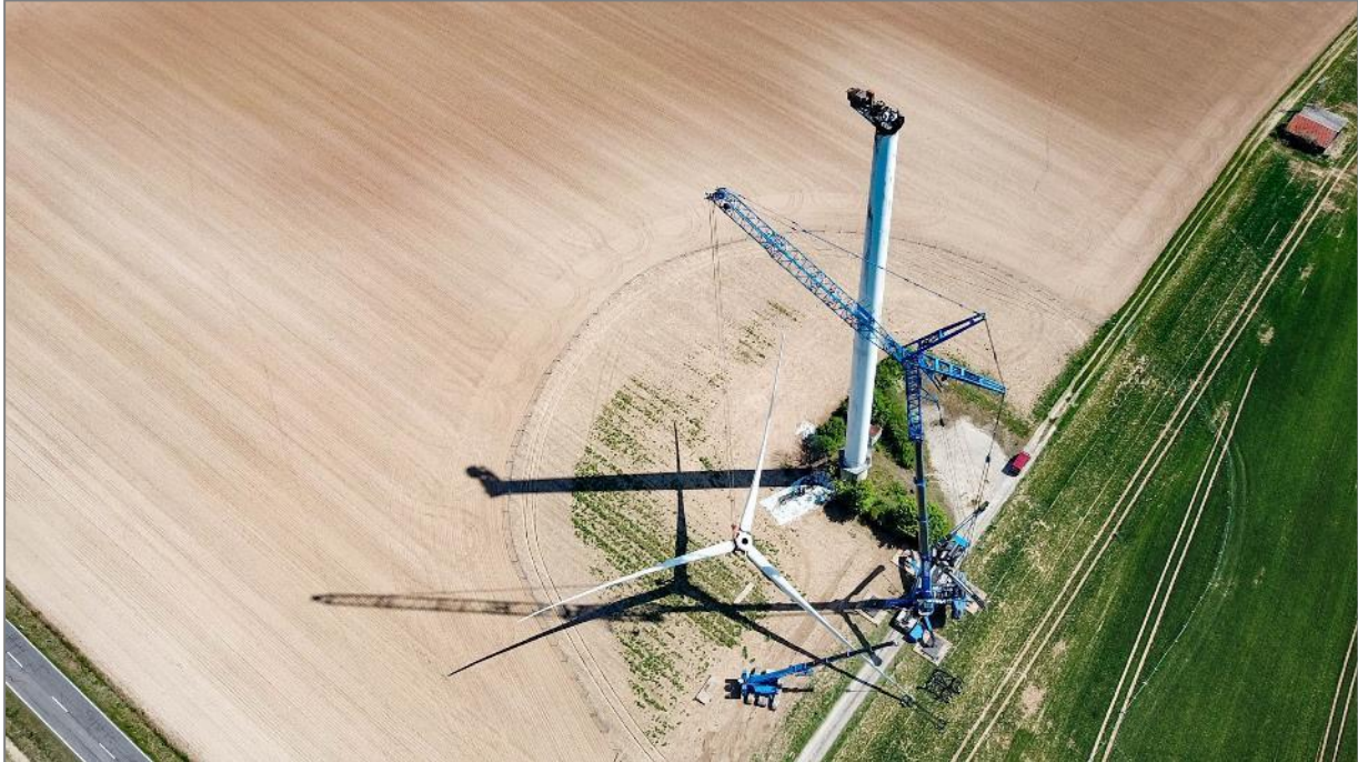
Abb. 5: Abbau der Rotorblätter als ganzer Rotorstern (© Neowa GmbH, www.rdrwind.de )
