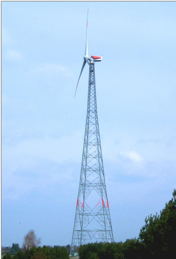
Abb. 6: Gittermastturm (© SPBer in Wikipedia, CC BY-SA 2.0, via Wikimedia Commons, https://commons.wikimedia.org/wiki/File:Windkraftanlage_Laasow.jpg )
