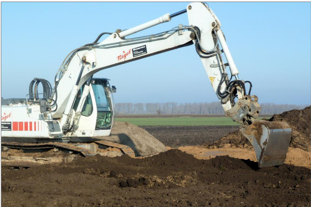
Abb. 11: Aufbau einer durchwurzelbaren Bodenschicht (© Schnittstelle Boden)
