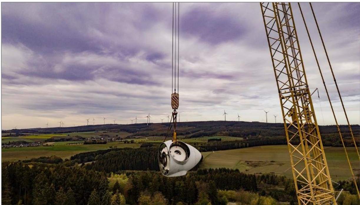
Abb. 17: Demontage der Nabe (© wiwi consult GmbH & Co. KG, www.wiwiconsult.de )
