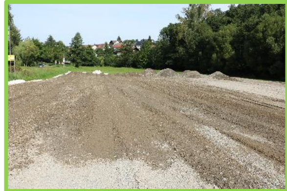
Abb. 15: Geotextil und Schotterschicht zur Vermeidung von Bodenverdichtungen (© Schnittstelle Boden)
