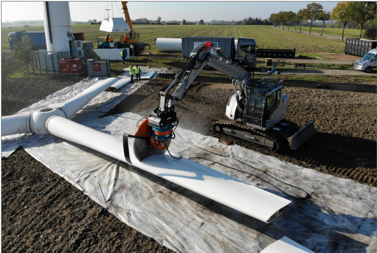
Abb. 16: Demontage eines Rotorblattes mittels Säge und Schutz des Bodens vor Staubeinträgen im unmittelbaren Umfeld durch Ausbreiten eines Geotextils (© Wörmann-Team GmbH & Co. KG, www.woermann-team-verkehr.de )
