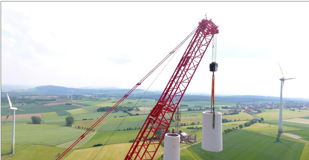
Abb. 18: Mechanischer Rückbau eines Betonturmes (© Hagedorn Unternehmensgruppe, www.unternehmensgruppe-hagedorn.de )
