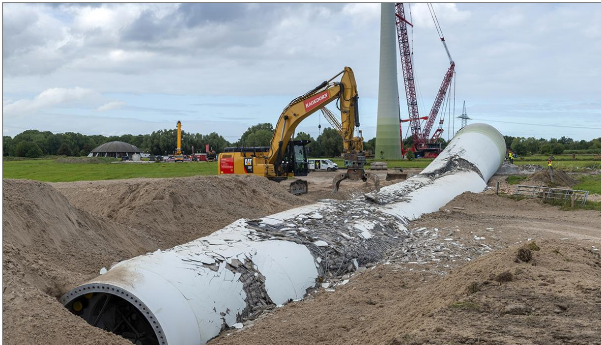
Abb. 22: Betonturm im Fallbett nach erfolgter Sprengung (© Hagedorn Unternehmensgruppe, www.unternehmensgruppe-hagedorn.de )
