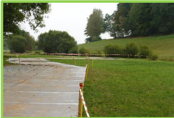
Abb. 14: Bodenschutzplatten (Lastverteilungsplatten) zur Vermeidung von Bodenverdichtungen (© Schnittstelle Boden)
