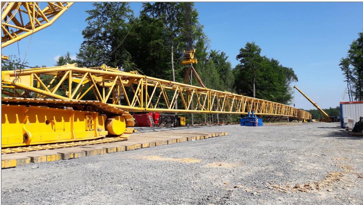
Abb. 4: Baustelleneinrichtung in einem Windpark (© Schnittstelle Boden)
