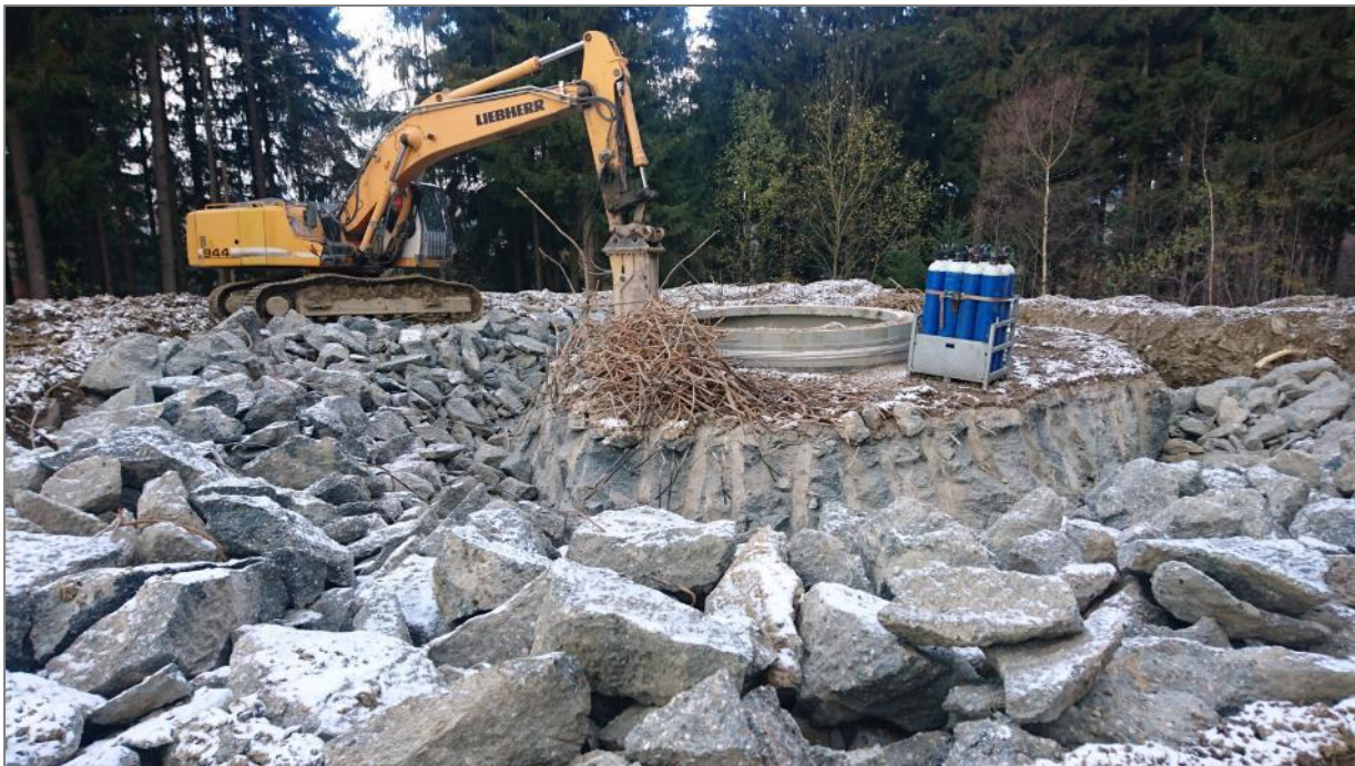
Abb. 19: Rückbau eines Flachfundaments (© wiwi consult GmbH & Co. KG, www.wiwiconsult.de )
